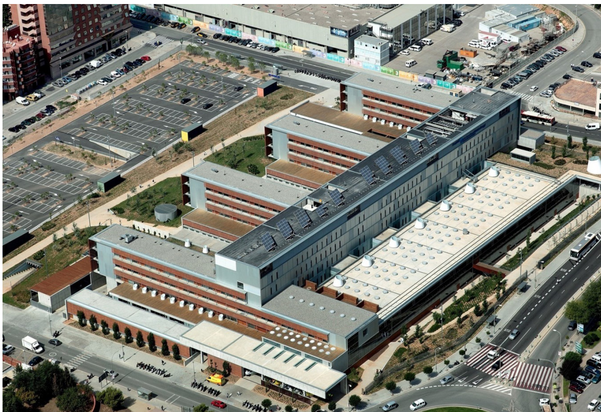
Tipologia ospedaliera a sviluppo orizzontale con un corpo principale e padiglioni connessi dell'ospedale di Sant Joan Despi Doctor Moises Broggi - Barcellona, Spagna - PINEARQ
