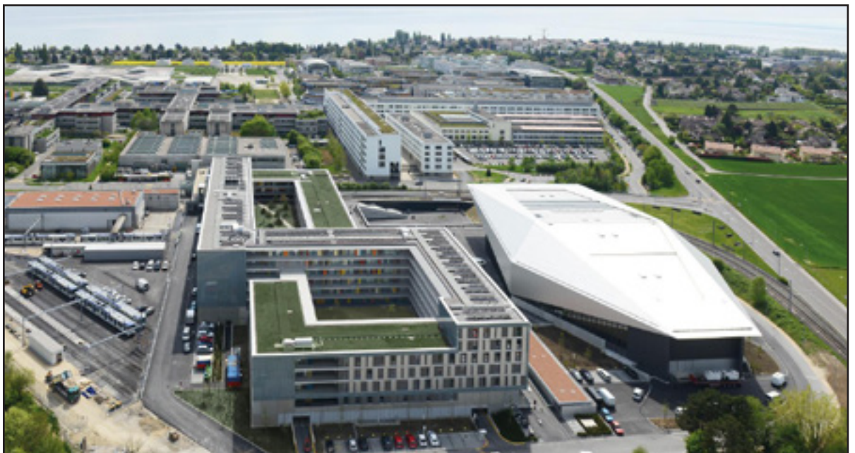
RDR architectes, mixité fonctionale nel Quartier Nord, Student Housing; Ecubles, Svizzera, 2013
